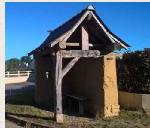
Saint-Juvat (22) : construction d'un abri de car en terre, via un chantier-école
