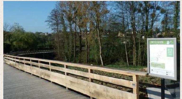
Vignoc (35): une passerelle en bois pour rejoindre l'arrêt de car
