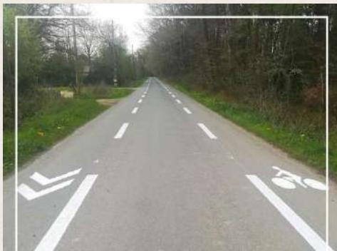
Plessé (44): mise en place d'un chaucidou
