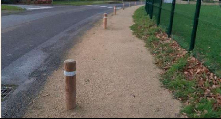
Plerguer (35): stabilisé fait et posé en régie
