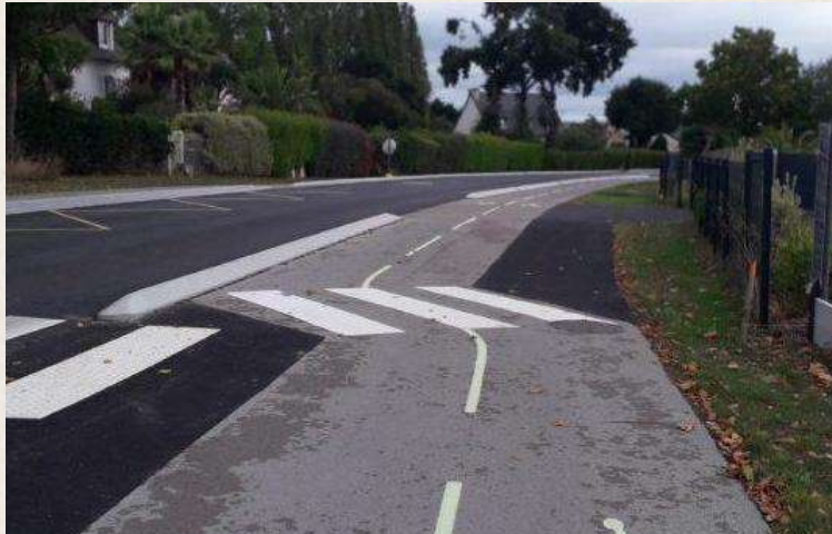
Plérin (22): enrobé drainant avec l'évacuation des eaux pluviales dans les noues situées sur les bas-côtés
