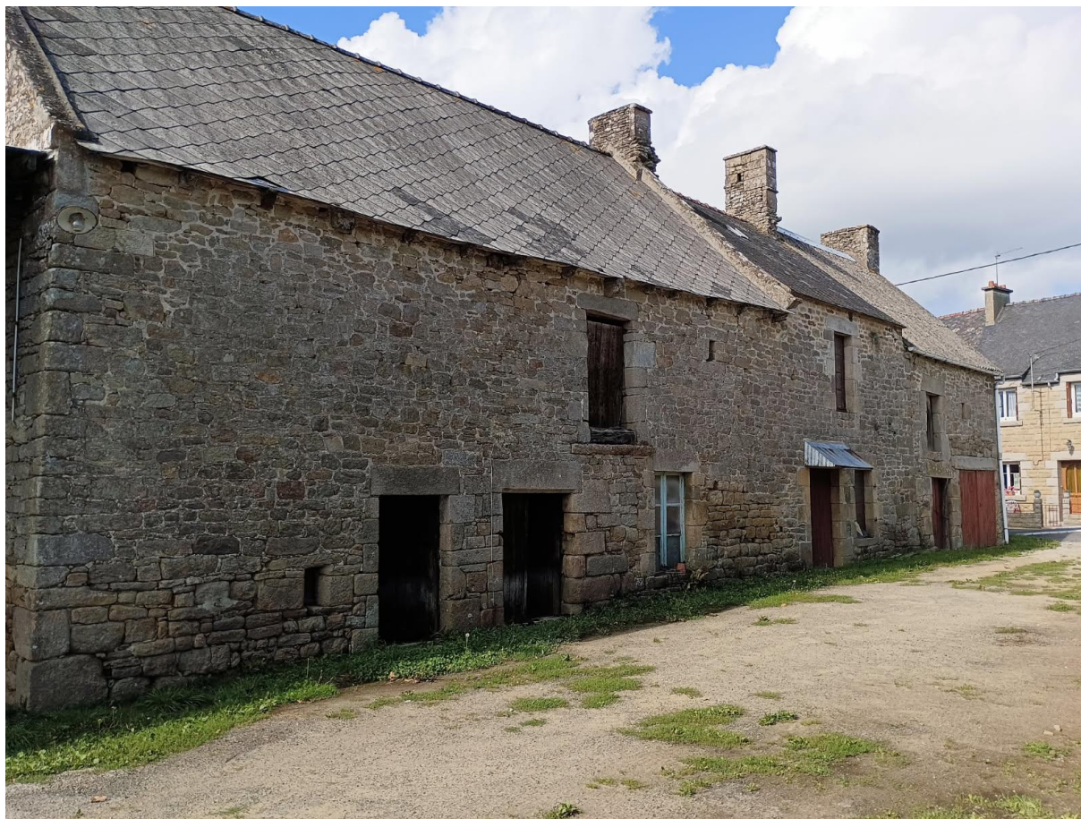
Maisons 3 et 4 du projet global de rénovation du Vieux Bourg
