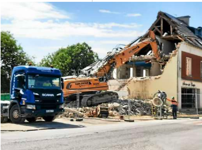
Démolition de l'aile Est, 2021
