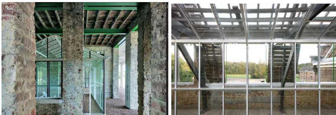
Requalification d'une ruine à Melle - Jan de Vylder, Inge Vinck et Jo Taillieu (adVVt)
