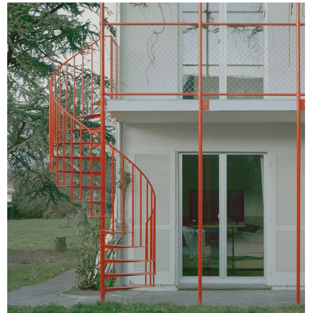
coursive et escalier extérieur métallique par Dominic Spalt Architektur
