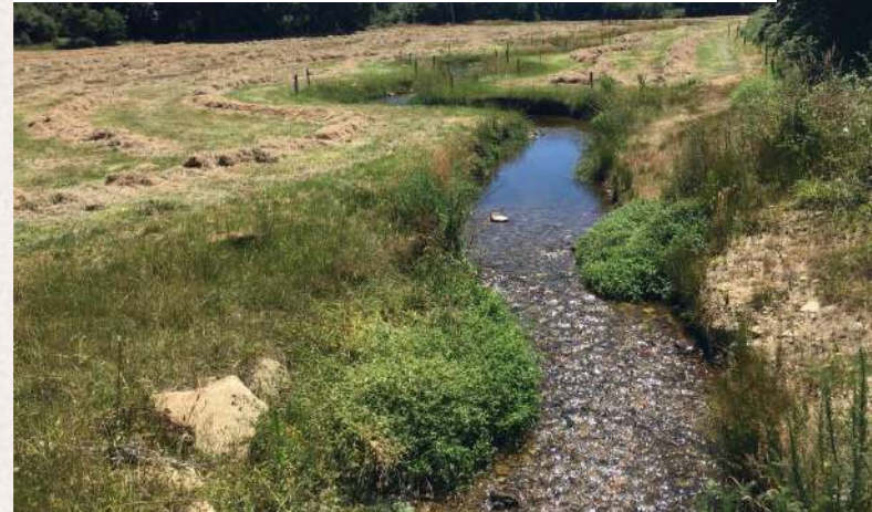
Débuser et reméandrer un cours d'eau au Juch (29)
