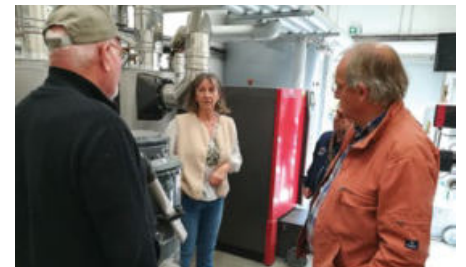
— Petit détour par la chaufferie bois lors de la visite du restaurant scolaire commentée par Françoise Guillem, maire de Langonnet (56).
