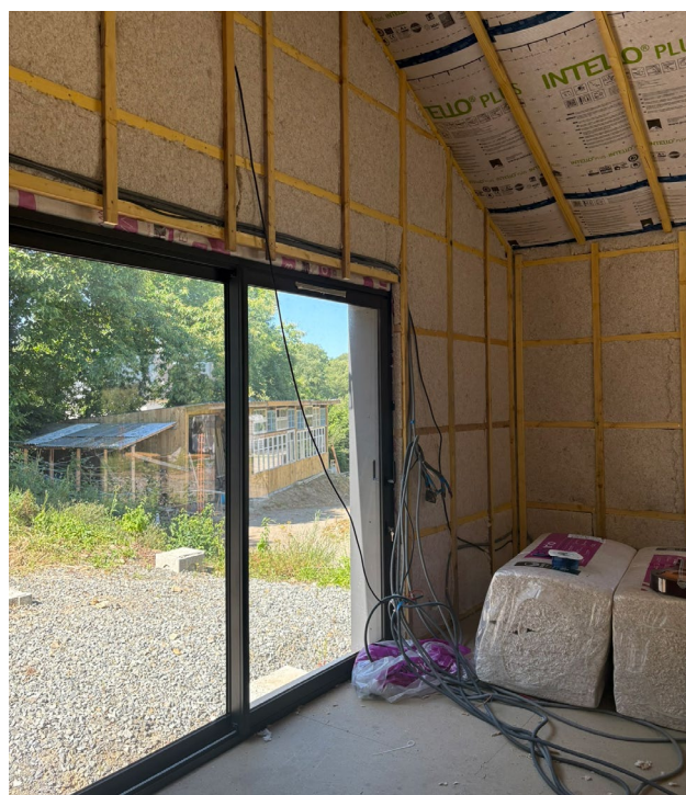
Travaux dans un prototype d'habitat réversible à Commana (29).
