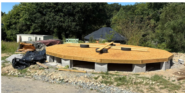
Fondations d'un des habitats réversibles du hameau de Commana (29).
